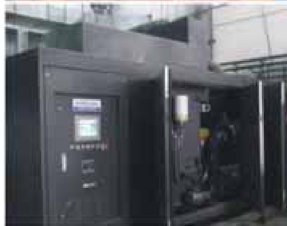
Пусконаладка компрессора SAMSUNG Sm4000
